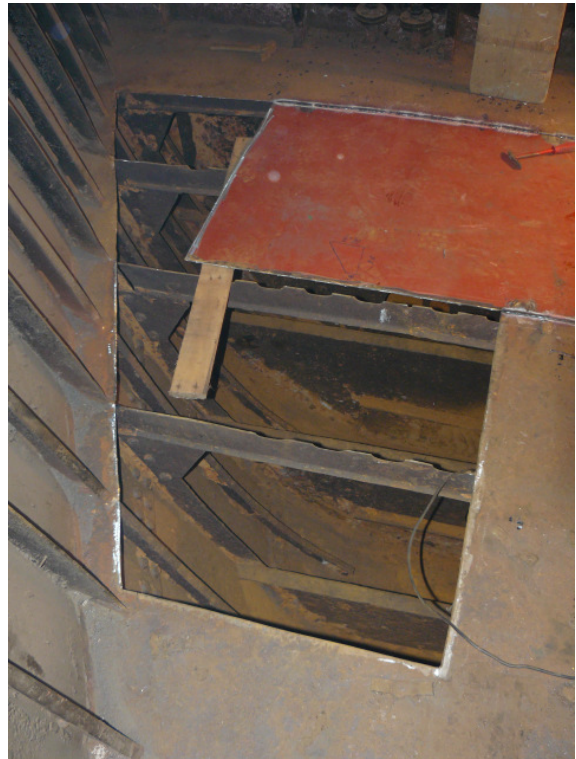
Blick in den gefegten Ballasttank
